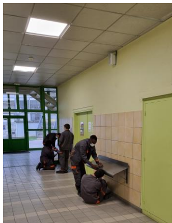
Pose des bancs « assis-debout »
